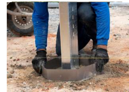
União da forma e colocação em torno do pilar para a concretagem
