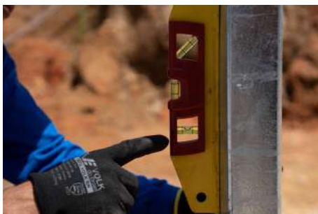
Verificação do prumo e nível de cada pilar
