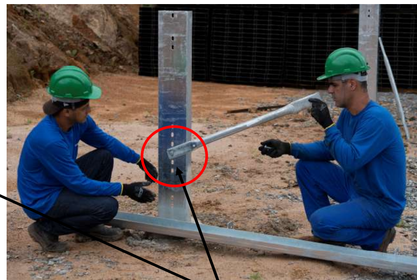
Fixação da mão francesa no furo indicado por projeto
