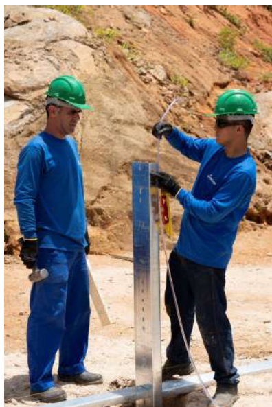
Verificação do prumo e nível de cada pilar
